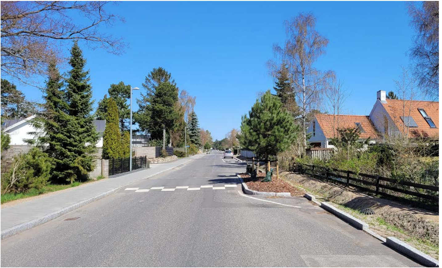
Gl. Køgevej. Renoveringen er næsten færdig. Kun ny asfalt mangler.
