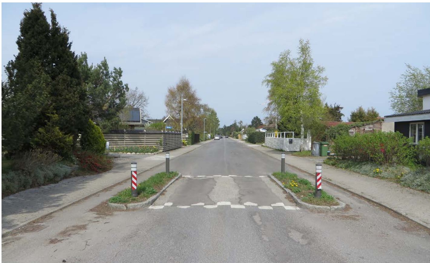
Gl. Køgevej før renoveringen.
