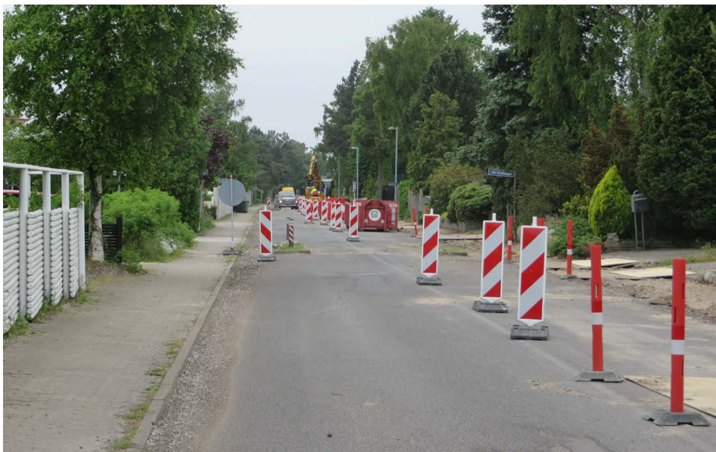
Gl. Køgevej bliver renoveret.
