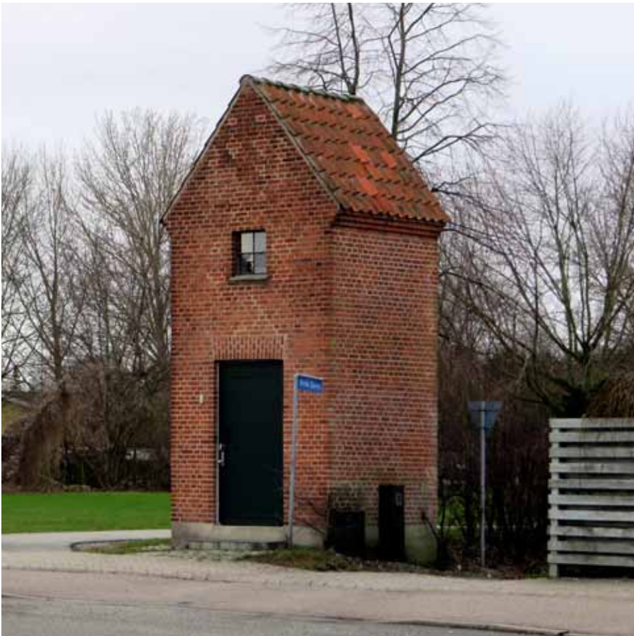
Det Kulturelle Transformertårn, februar 2016
