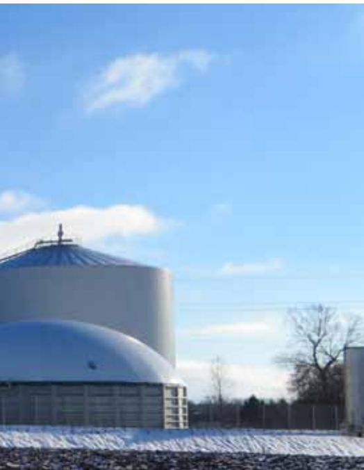
Januar 2016 - Biogasanlægget i sne og solskin
