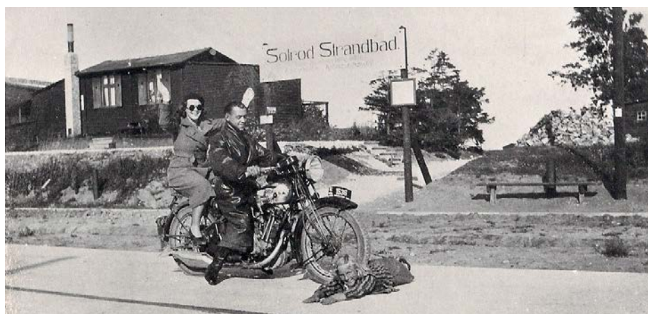
Betonvejen ved Solrød Strandbad
