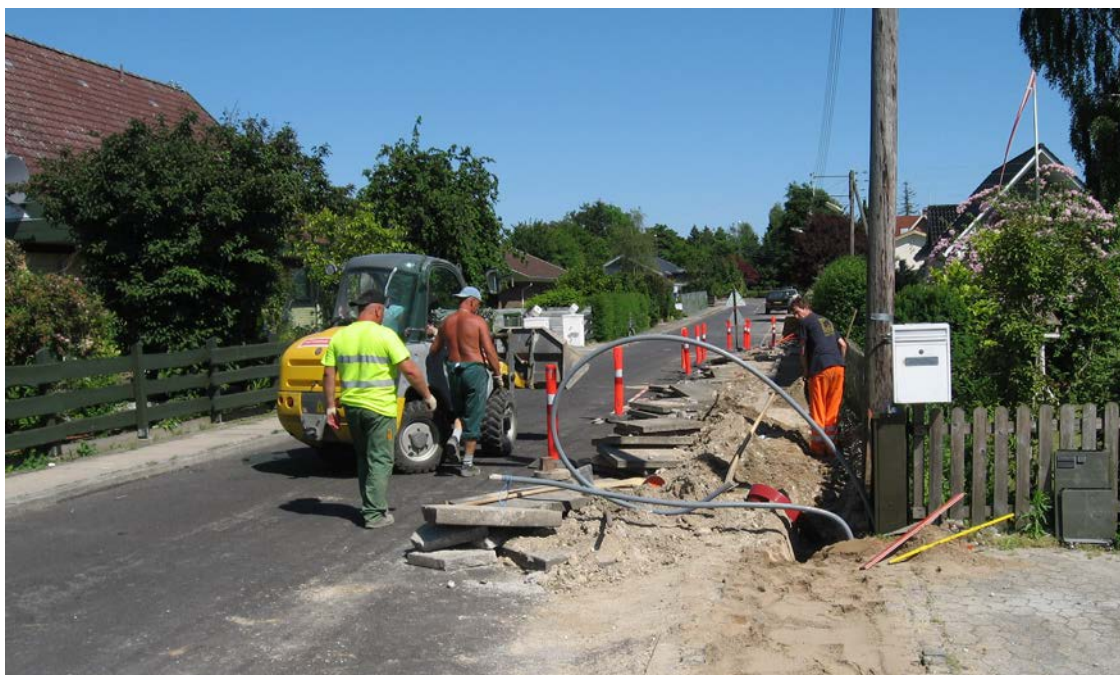
Fra luftledninger til jordledninger
