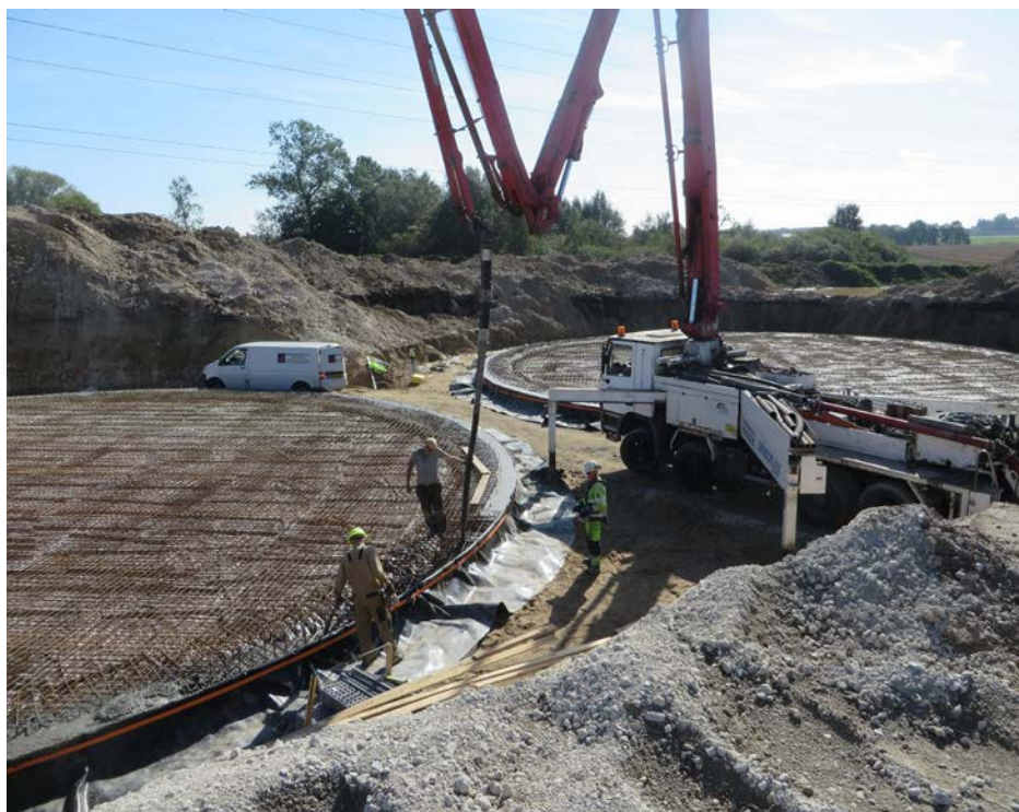
Et biogasanlæg bygges
