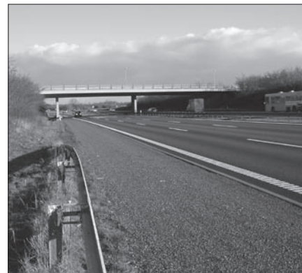
Midt i Solrød er der støjdæmpende asfalt både mod nord...
