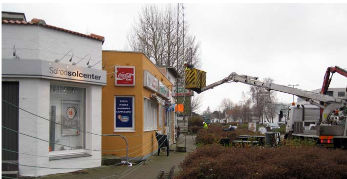
En af de sidste elopgaver - De gamle master og elledninger på Strandvejen fjernes.
